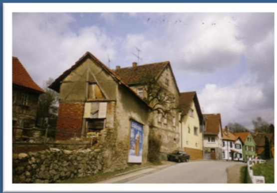
Der Hof der Familie Rauth vor dem Abriss der Scheune. Das Wohnhaus wurde 2006/07 komplett saniert.
